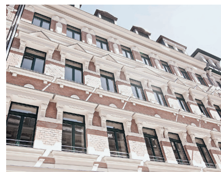
Sanierte Fassade eines Objekts in der Leipziger Gutsmuthstraße
